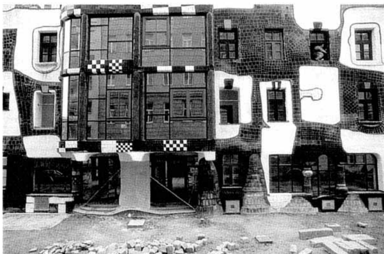
Fassade im Bau
